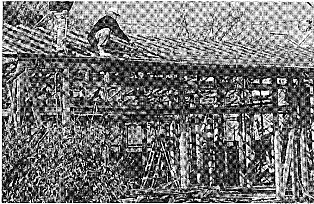
写真 2-1 木造軸組構法の解体工事
