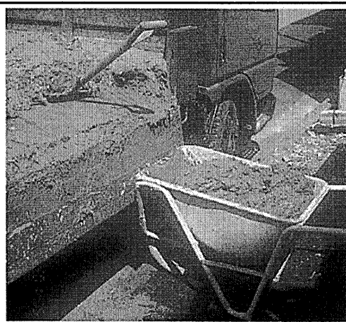
写真4-1 規格材による小舞掻き 写真4-2 ネコによる泥コン運搬
