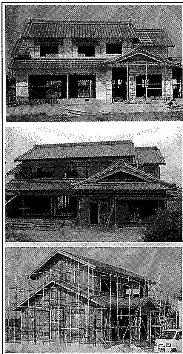
写真3-1, 2, 3 土壁住宅農家型の実例, 豊橋(上, 中), 安城(下)
