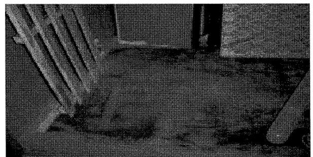
写真 4-3 押入床面に発生したカビ(住宅 No.6)
