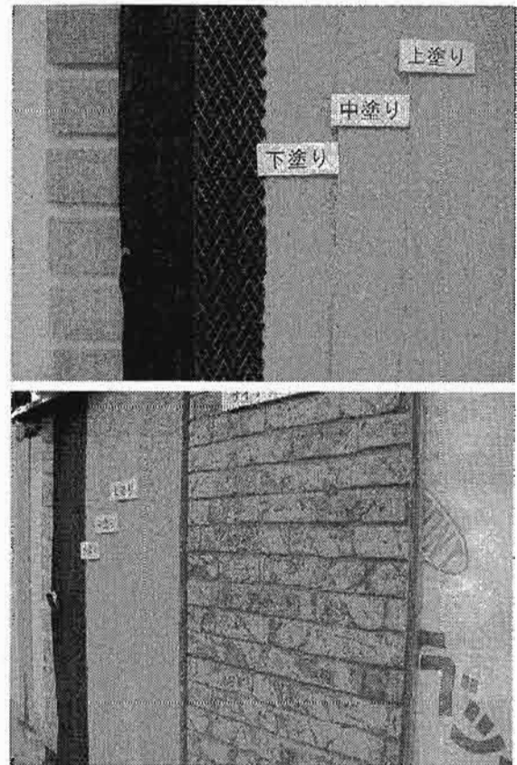
写真 2-1 外壁の層構成の一例
