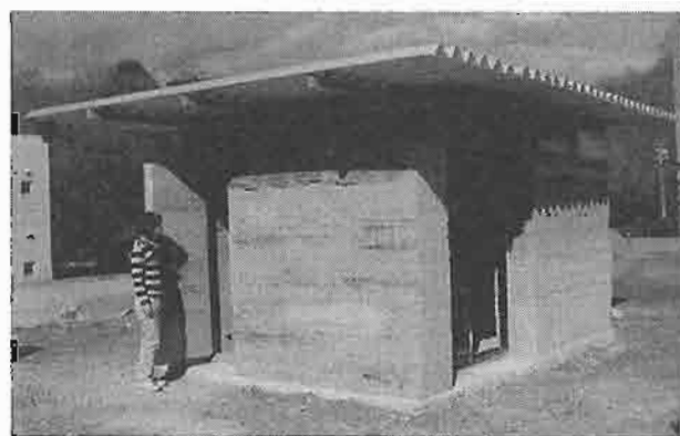
図1-1 版築造実験居室全景
