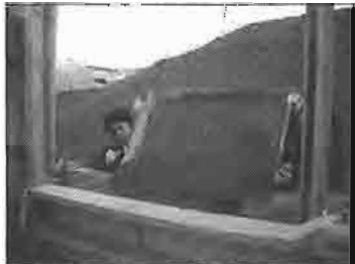
図3-15 型枠に土を入れる
