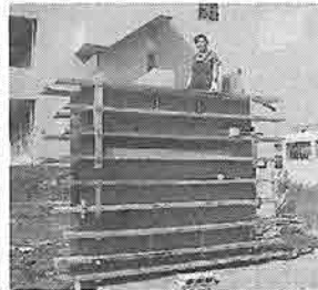
図2-11 採用した型枠
