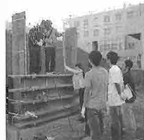
図3-10 試作版築壁づくり
