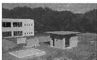
図6-1 左下建設中の2棟目版築実験居室と右完成した1棟目 2002.11 現在
