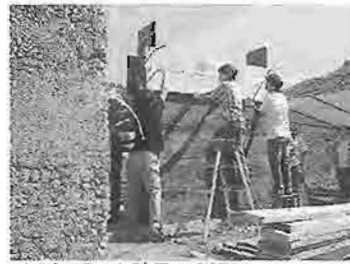
図3-17 1壁目の脱型
