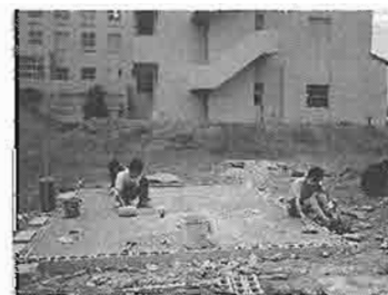
図3-13 版築造実験居室基礎づくり
