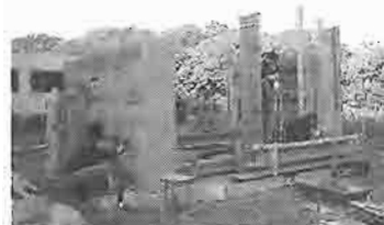
図3-20 4・5壁目の施工
