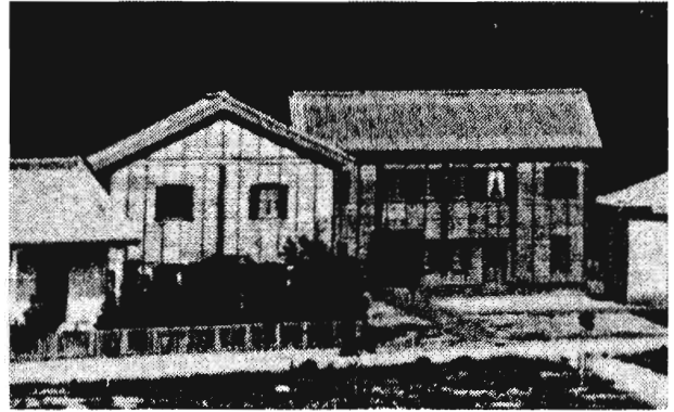
写真3-4 西側から見た2棟の頭目住宅(参考文献7 p.33)
