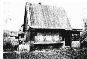
写真8 ダーチャ小屋外観
