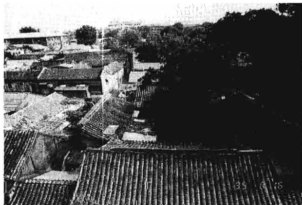
写真2-1 詳細調査対象地区の全景
