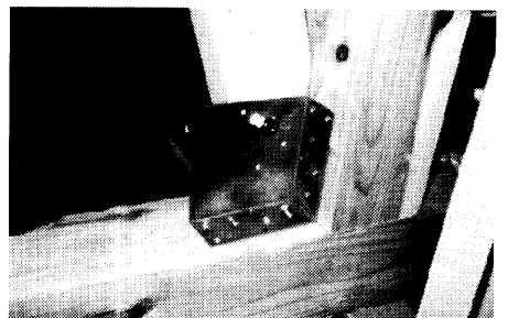
写真7-4 土台から木ネジが引き抜けた箱型筋違い金物（SGB：柱からはほとんど引き抜けてない）
