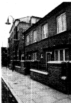
写真1 建替後、接地・住戸直接アクセス型住棟
