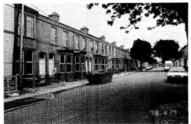
写真3-2 グランビィのテラスハウス (リバプール)
