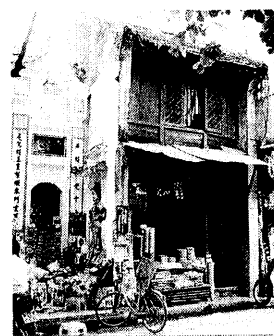
写真5-5a 第3期街屋外観
