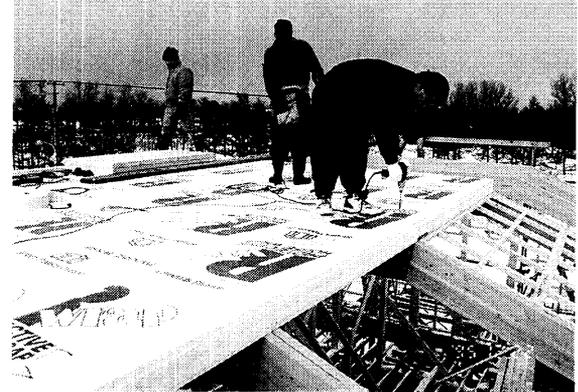
写真 7-7 屋根パネルを梁にビスで留め付けている状況。基本的な納まりは外壁パネルと同じ。
