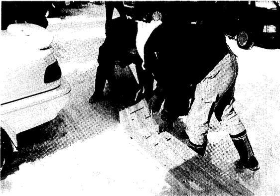
写真 7-2 登り梁の集成材をドリフトピンで組み立てている状態。
