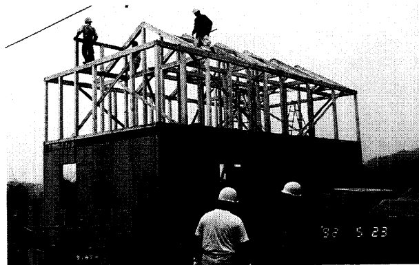
写真-2.1-2 1階PC造+2階木造
