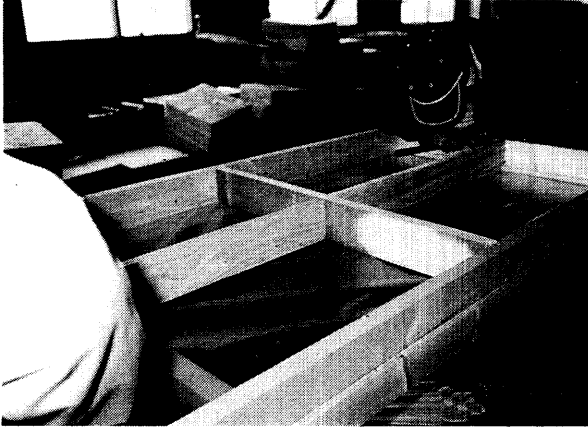
写真5-1 パネル木枠の組立てと防湿材の取付け
