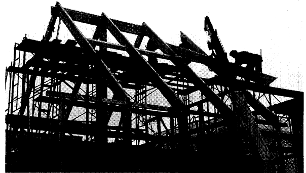
写真5-4 2階軸組（集成材）の建込み
