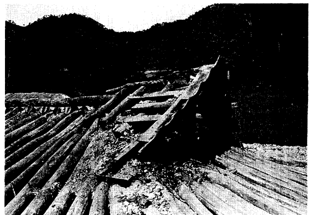
写真2-2 屋根入母屋部の小屋組み
