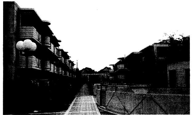
写真3 低層集合住宅
