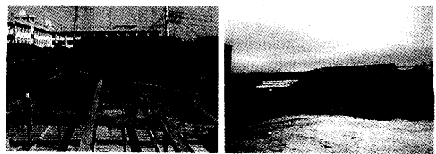
写真1-7 屋根の離脱 写真1-8 屋根の離脱
