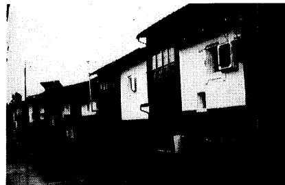
写3-1 修景前の瀬戸川と堀川通り
