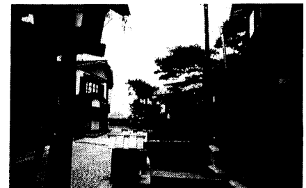
写4-2 弁財天堂と修景された堀川通り
