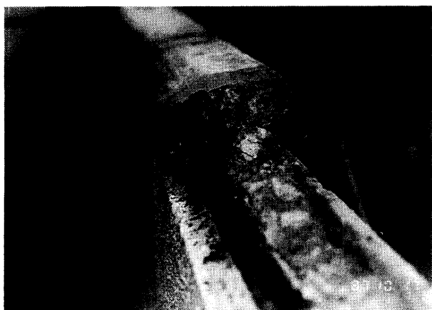
2 縦筋の笠木へののみ込み不足と化粧目地底に当たった横筋の発錆による水平クラックにより笠木が浮いた。
