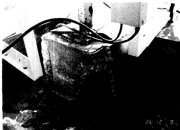
2 10m 3 の高置水槽の鉄骨架台の基礎は型枠代りの既製排水 水樹にモルタルを詰めただけのもの。はつてみると建 物本体にはアンカーされていない、ただ置いてあるだ け。
