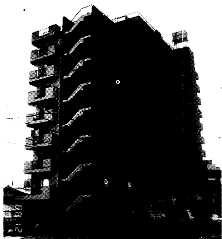
1. マンション全景。右上塔屋の上(地上40m)に見えるのが ・高置水槽。1階店舗下全面が巨大な地下ピットになって いて、その中に受水槽、ポンプが設置してある。
