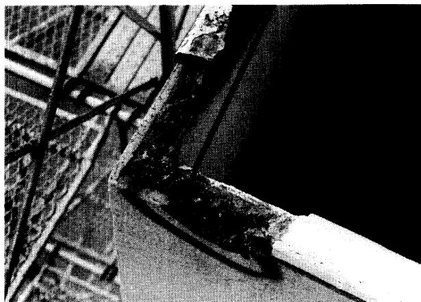
1 テストハンマーで叩くだけで欠け落ちるコンクリート手すりの笠木。
