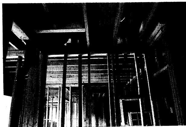
図1 北米の木造集合住宅の配管の例
