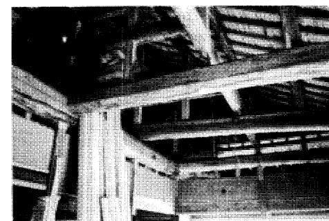
写真一 2. 5 継承されている土壁構法
