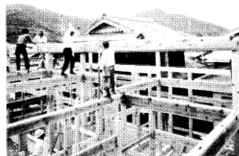
写真一 2. 3 杉を多用した小屋組
