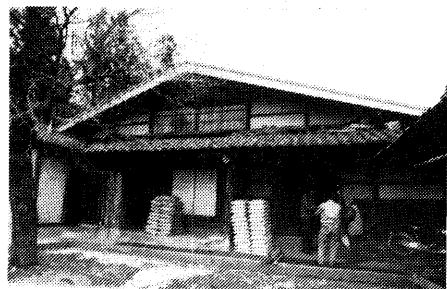
写真-1 本棟造りの正面外観（諏訪藩農家） 長野県松本市中山（住戸 No. 29）
