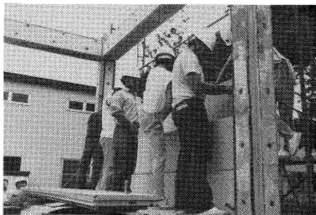
写真5-1 壁板の取り付け
