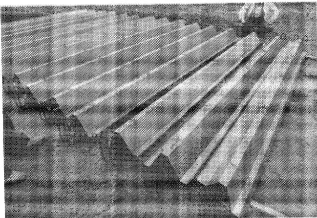
写真 2-7 床用捨て型枠
