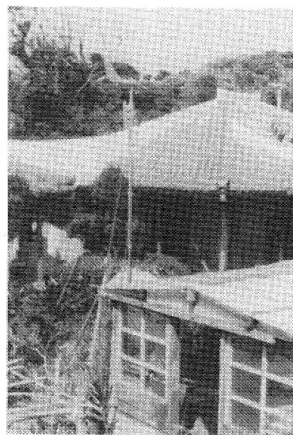
写真-2 山城家の風速計設置状態
