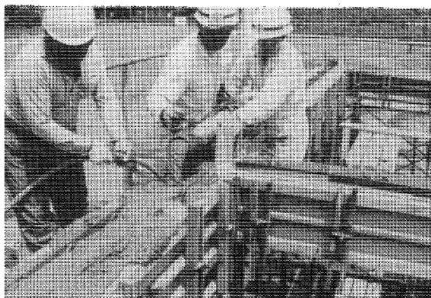
写真4-9 梁への打設
