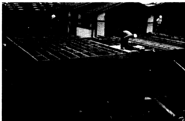
Fig. 2-5 桝組壁Gの建方
