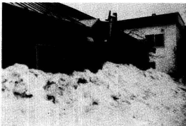
図3.1 屋根雪の落下と窓
